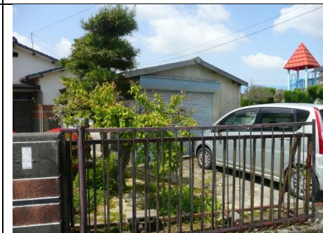
倉庫・駐車場
