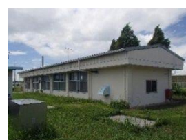
瀬高浄水場更新事業 (管理棟,送水ポンプ等)
