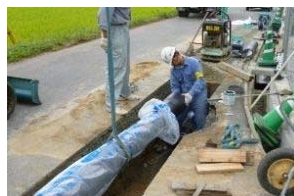
老朽化管路更新耐震化事業 (送水管,配水本管,配水支管)
