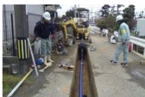
老朽化管路更新耐震化事業 (送水管,配水本管,配水支管)
