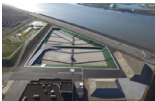
ごみを焼却した際に発生する焼却灰を埋め立てる最終処分場の2期工事が完成しました。工事の完了により、今後約15年間焼却灰の埋め立てが可能となります。
