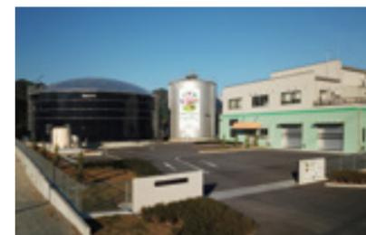
みやま市バイオマスセンター「ルフラン」では、生ごみ10トン、し尿42トン、浄化槽汚泥78トンの合計130トンを受け入れています。それらをメタン発酵によりガスを発生させ、発電を行い、施設内の電力と温水として活用します。発酵後の液体は、液肥として水稻や麦などの栽培に利用されています。エネルギー使用量の削減やJ-クレジットの認定など、大きな効果を生み出しているのは、市民の皆さんに生ごみ分別に協力していただいているおかげです。引き続き、生ごみ分別へのご協力をお願いします。
