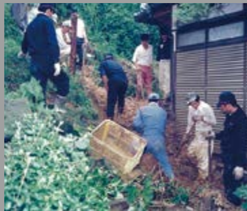
平成2年豪雨 土砂の撤去作業
