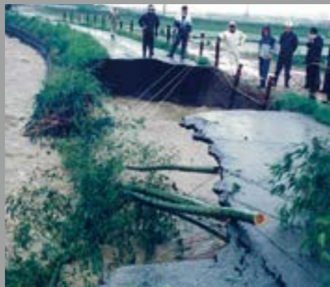
平成2年豪雨 木流し工法で崩壊の拡大を防ぐ
