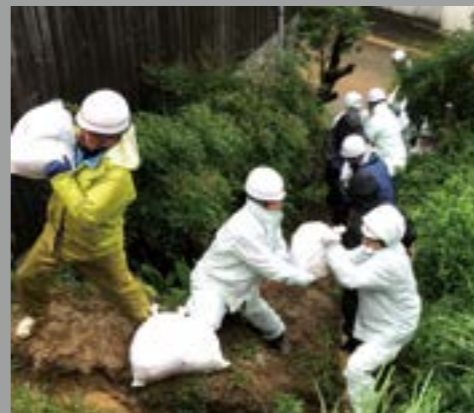
令和2年7月豪雨 崖崩れを防ぐシート張り
