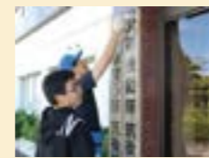
▶看板のニス塗布作業
