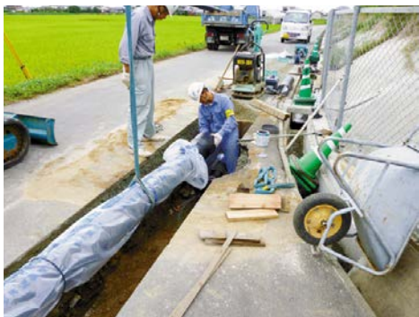
ライフラインとなる水道管の敷設替え
