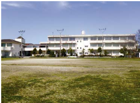
廃校になった竹海小学校跡地
