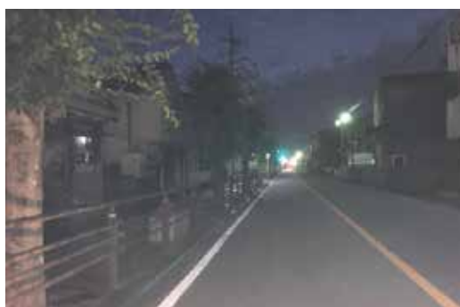
早急な「安全灯」の整備が待たれる 街灯一部撤去で暗くなった瀬高駅前歩道
