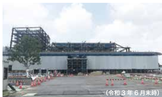
令和4年秋開館に向けて建設中の(仮称)みやま市総合市民センター
