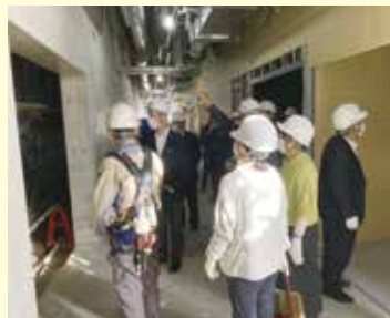
みやま市総合市民センター建設現場
