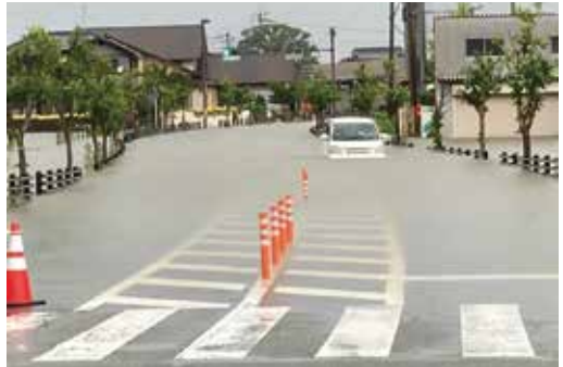
8月豪雨時の瀬高小学校前冠水道路
