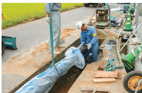
水道主要管の布設替え
