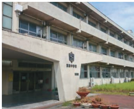
建て替えを待つ瀬高中学校
