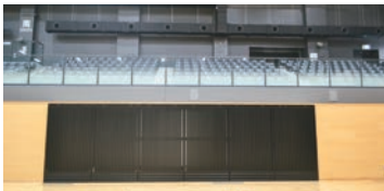
輻射熱空調（冷房）設備設置の体育館
