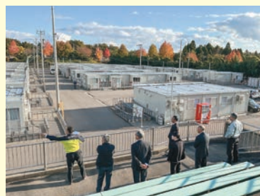
▲穴水町の仮設住宅
