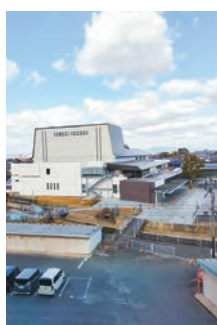
雨漏り調査中の 総合市民センター
