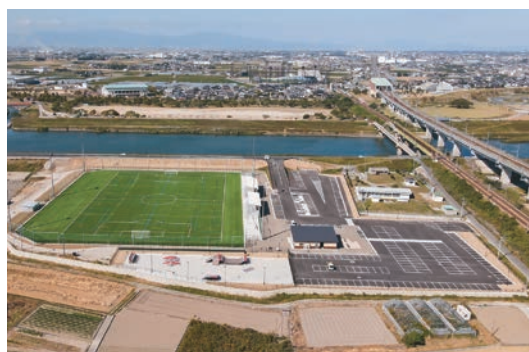
スポーツツーリズムの核となる筑後広域公園
