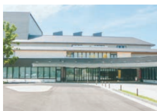
雨漏り原因調査中の 総合市民センター
