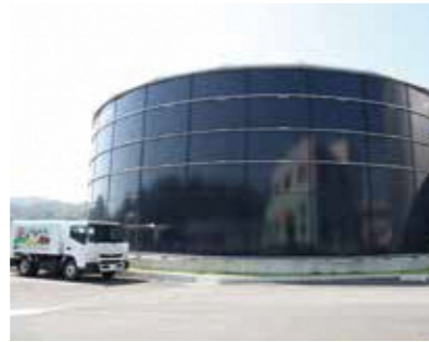
消化液貯留槽
