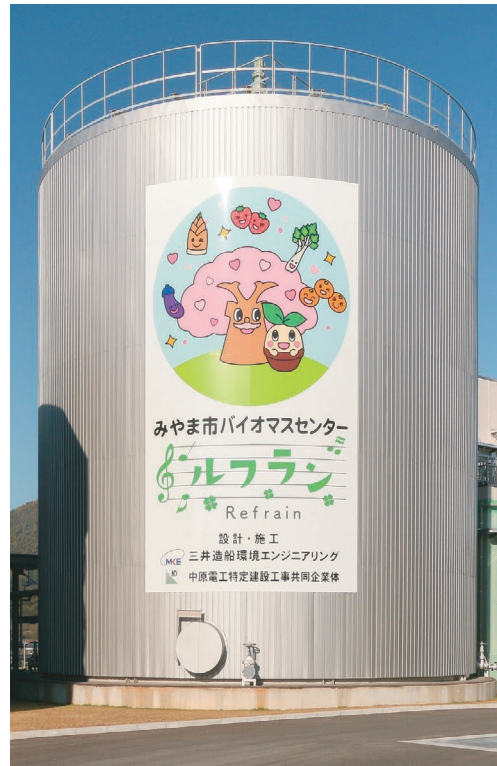
メタン発酵槽
