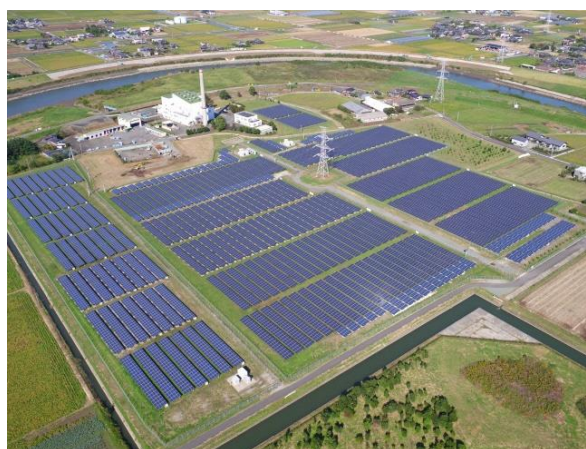
みやまエネルギー開発機構の 約5MWメガソーラー
