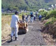
未舗装農道の舗装
