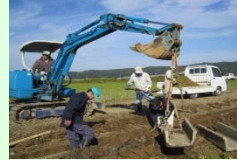
コンクリート水路の更新
