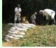
漏水箇所の補修
