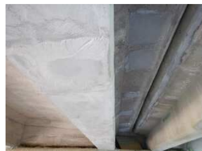
クノエ橋（R C T 桁橋）：主桁の鉄筋露出部分にモルタルを埋め断面修復を実施。（2016年補修実施）
