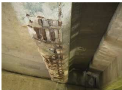
クノエ橋（R C T 桁橋）：主桁の鉄筋露出部分にモルタルを埋め断面修復を実施。（2016年補修実施）
