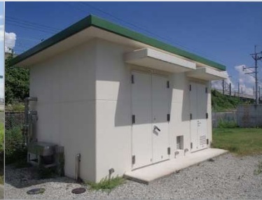
薬品タンク室・制御室
