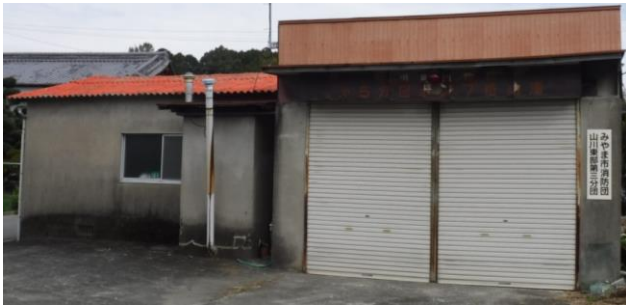
コンクリートスレート1階建 格納庫(築46年)
