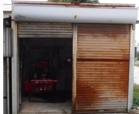
山川町上伍位軒手引きポンプ格納庫
