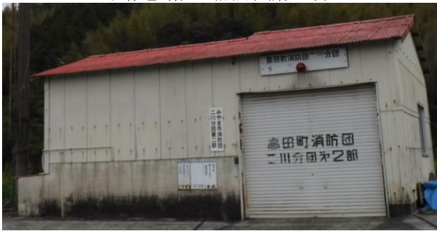
鉄骨造1階建 格納庫(築43年)
