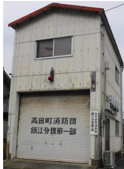
鉄骨造2階建 格納庫(築41年)
