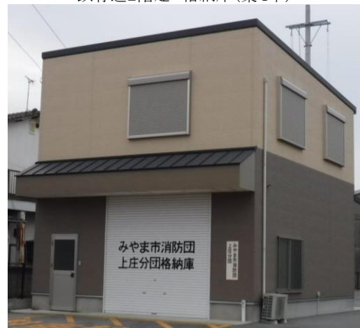
鉄骨造2階建 格納庫(築4年)
