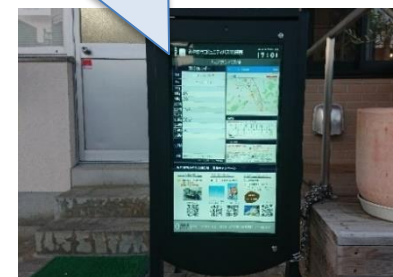
ルフランにおける スマートバス停設置状況
